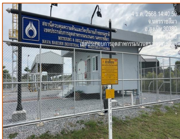
สถานีควบคุมความดันและวัดปริมาณก๊าซ และ ป้ายเตือนแนวท่อส่งก๊าซ
